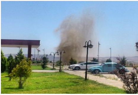
Şekil 3: Doğalgaz hattının zarar görmesi
