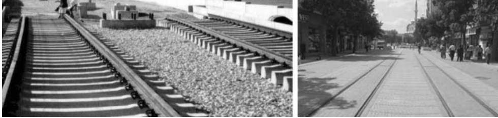
Şekil 8: Balastlı Hat (BursaRay) ve Balastsız Hat (Estram)
